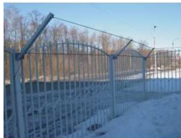
Козырьковые варианты установки проводноволнового датчика
